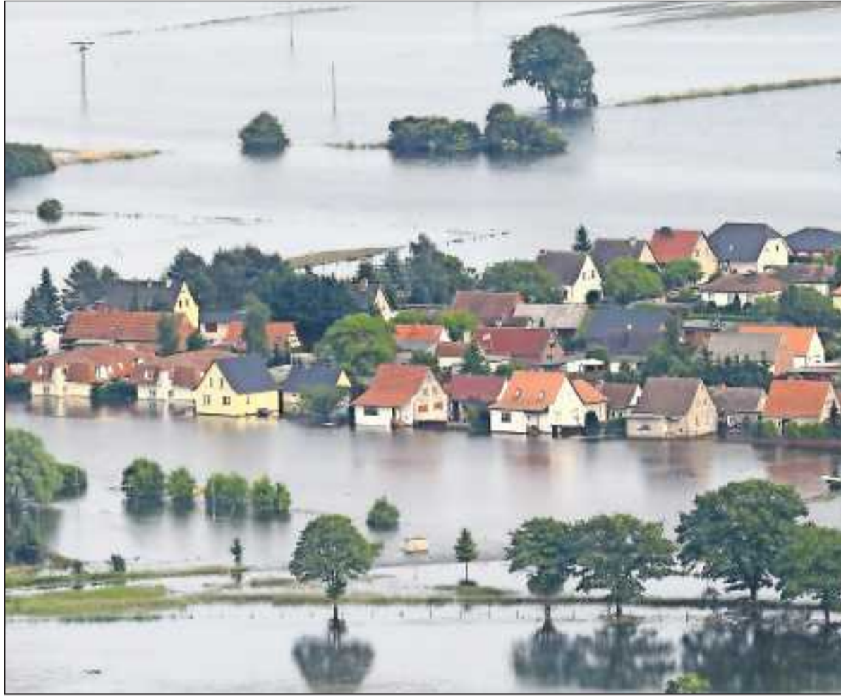
Hochwasser an der Elbe im Jahr 2013: Der Ort Fischbeck in Sachsen-Anhalt wurde überflutet, weil der Deich brach. FOTO: DPA
