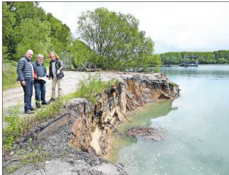
Begutachten den Uferabbruch: (von links) Firmenchef Axel Rohr, Ortsbürgermeister Bernd Zimmermann und Prokurist Robert Gard. Im Hintergrund ist der Schwimmbagger zu sehen.
